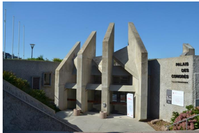
Palais des Congrès, vue générale depuis l'est, entrée principale
