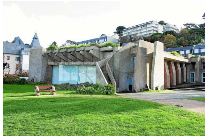
Palais des Congrès, vue générale depuis le nord, côté océan
